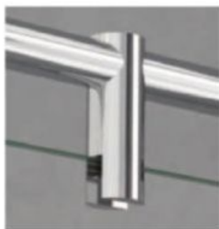
Detalle de fijación a vidrio
