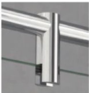
Detalle de fijación a vidrio
