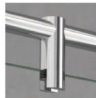
Detalle de fijación a vidrio
