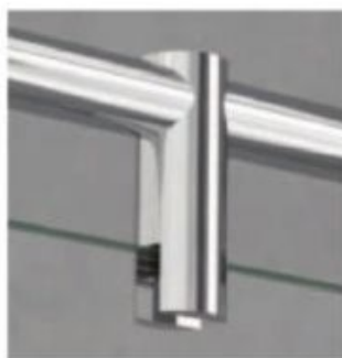
Detalle de fijación a vidrio
